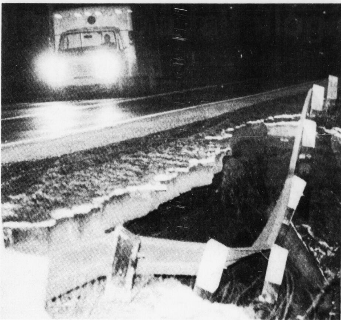
GLISSEMENT — Une portion du bord de route s'est effondrée, dans le parc des Laurentides, hier, suite au tremblement de terre.
