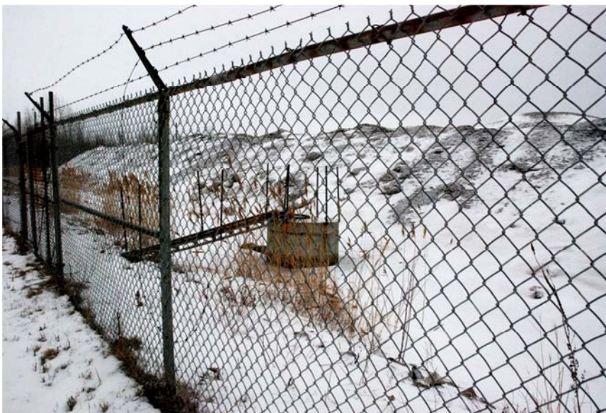
Puisard qui sert à évacuer le trop-plein du dépôt à neige dans le réseau sanitaire
