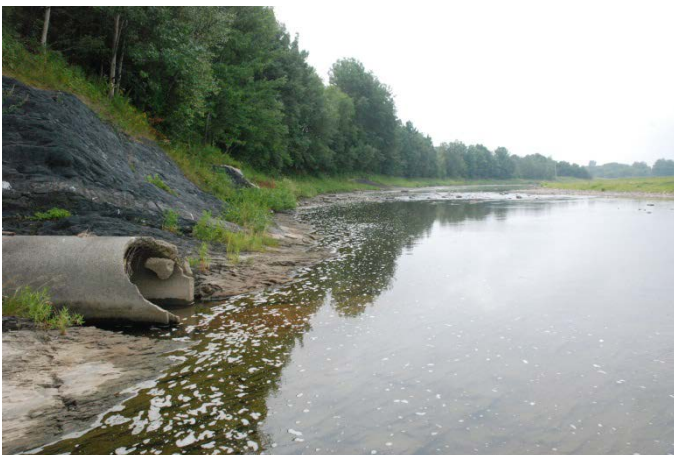
Sortie pluviale du secteur résidentiel au sud de la rivière Bulstrode en amont du réservoir Beaudet
