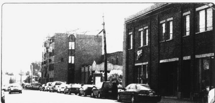
Les trottoirs seront refaits à partir de lundi prochain sur la section Est de la rue Richelieu, entre les rues Saint-Georges et Frontenac.
