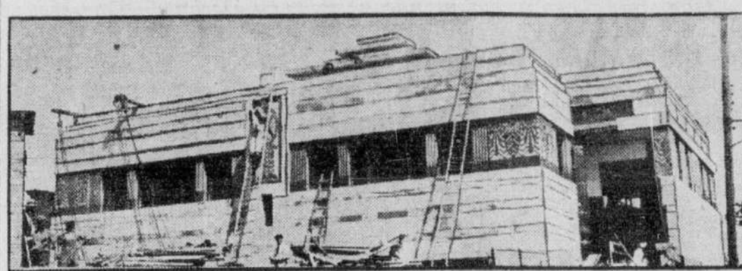
La dernière vespasienne, dont la construction fut ordonnée par l'ancienne administration, est à se terminer sous le nouveau régime. Elle est toute grande en sculpture. Elle est à l'approche du tunnel de la rue Wellington entre les rues Murray et McCord. Les ouvriers sont actuellement à mettre la dernière main à l'intérieur. On en voit ici l'extérieur complètement fini. — (Cliché la "Presse").
