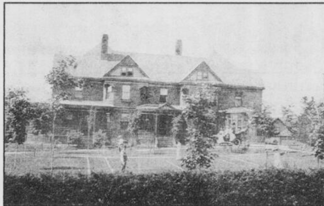
Un classique pour les résidents de Windsor; la luxueuse résidence de la rue Dearden (aujourd'hui rue Ambroise-Dearden). Le court de tennis sur gazon a depuis fait place à des espaces de stationnement. Aujourd'hui, on y fait d'important travaux de rénovation pour rendre conforme et moderne... l'hôpital Saint-Louis de Windsor.
