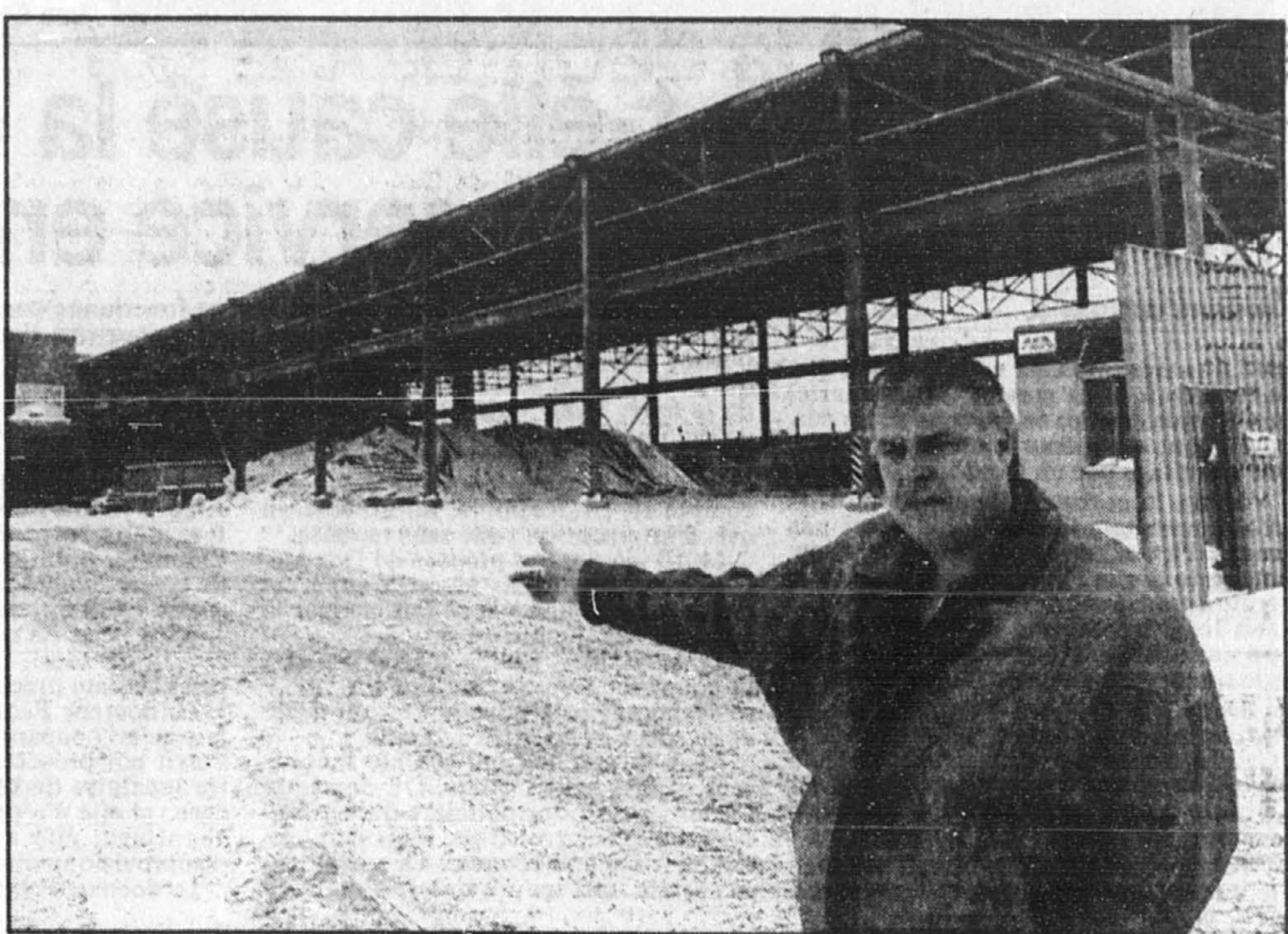
Pierre Boulé montre la nouvelle usine de Cintec qui traitera les sols contaminés à côté d'une vingtaine de maisons habitées.
