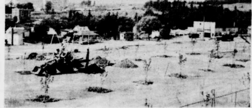
14 NOUVELLES RÉSIDENCES A BLACK LAKE — C'est au pied du talus du kiosque de l'Union musicale, que seront relogées les 14 résidences sur le point de mettre un terme à l'existence du village de Crabtree, à Black Lake. Ces nouvelles demeures s'élèveront en bordure des rues Bolduc (5), St-Hubert (5), et d'une nouvelle artère présentement désignée comme rue Crabtree (4). L'aménagement du site est en cours depuis hier, comme le démontre la photo ci-haut.
