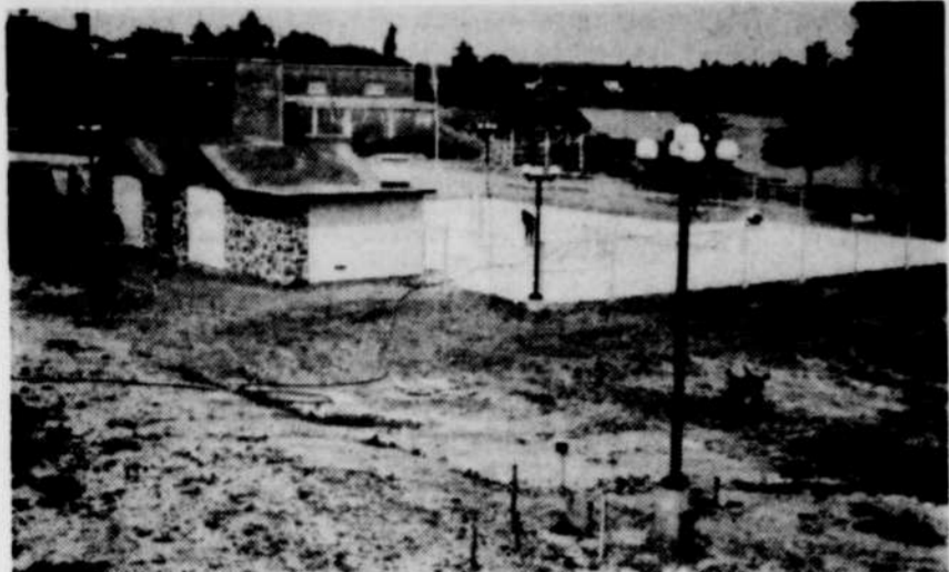
EBATS EN PERSPECTIVE — Avec la vague de chaleur qui sévit actuellement, les résidents du secteur Ste-Thérèse, à Drummondville, voient avec joie s'achever les travaux de la piscine du parc Ste-Thérèse, la toute dernière à être érigée dans cette ville. Sur cette photo, nous avons une idée de cette acquisition, avec au premier plan le pavillon des baigneurs et en arrière la piscine qui vient d'être peinte et qui devrait être inaugurée officiellement d'ici peu. (Photo La Tribune, Drummondville)
