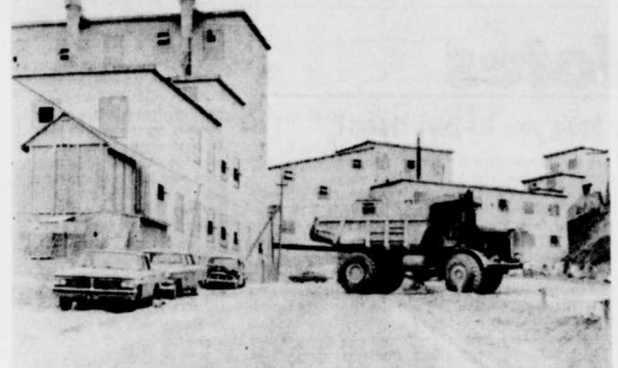
TRAGÉDIE A ÉVITER — C'est dans le but d'éviter de tragiques impacts entre ses lourds mastodontes de 45 tonnes, et les autos circulant entre l'ancienne route no 1 et le chemin de Crabtree et poursuivre ses opérations en toute sécurité, que l'Asbestos Corporation Ltd., de Thetford Mines, a convenu après entente avec la municipalité de Black Lake, de procéder au déménagement des 16 maisons résidentielles de cette petite agglomération. Quatorze de ces bâtisses seront relogées à Black Lake, tandis que les deux autres ont été vendues à la compagnie pour démolition. La photo ci-haut illustre bien les dangers qui planent sur les automobilistes sillonnant la route de Crabtree, laquelle est encerclée par les usines de la mine British Canadian, filiale de l'ACL.
