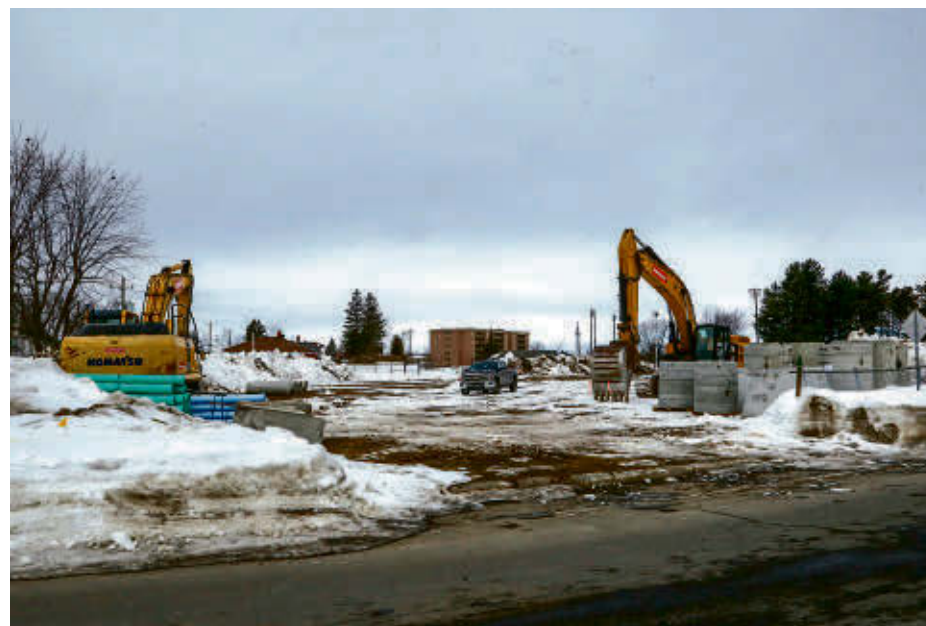
Les travaux du projet résidentiel situé au 125, rue Tétréau, sont déjà commencés. Photo Pascal Cournoyer | Les 2 Rives ©
