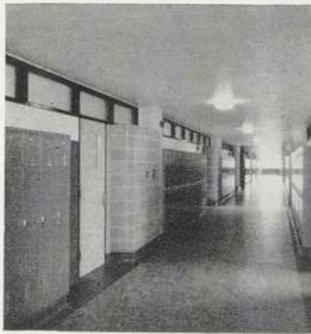
Vues sur un corridor et sur un puits d'escalier. La main courante de ce dernier, d'aluminium, s'ancre à un garde-fou de béton brut de décoffrage.
