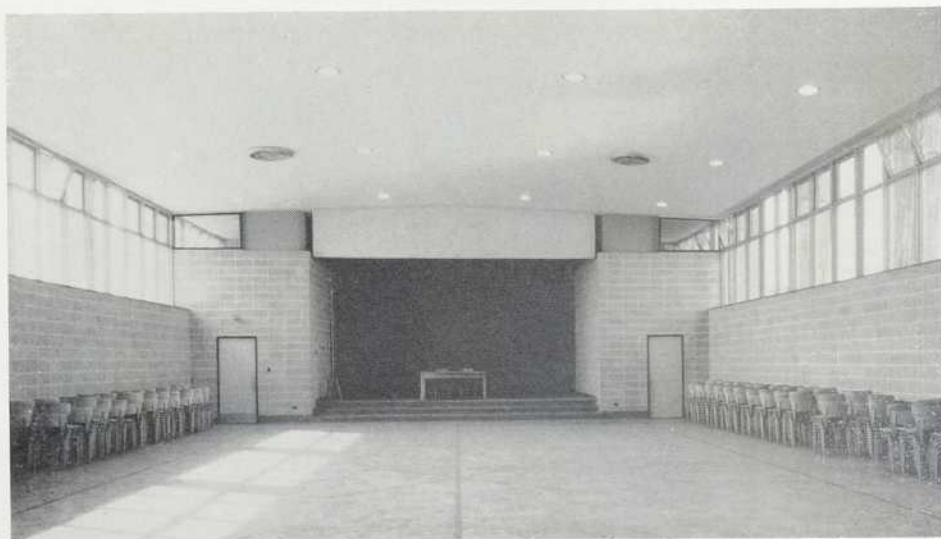
Vue intérieure sur la salle de récréation.
