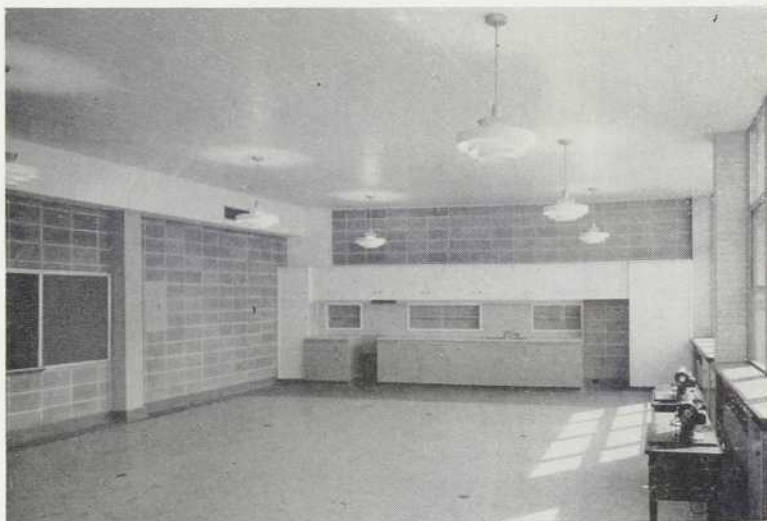
Trois vues intérieures illustrant une classe, la salle des professeurs et la classe d'enseignement ménager. Partout, on note le même respect pour la nature des matériaux. Les blocs d'agrégat léger gardent leur fini naturel et s'aboutent à la structure sans la camoufler. On échappe ainsi à la monotonie sans avoir à chercher ou inventer des moyens de diversifier le décor.
