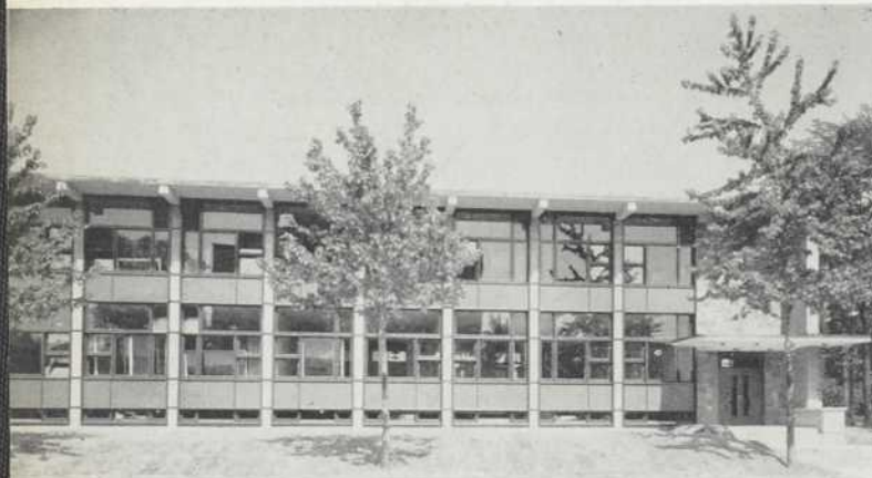
La façade principale, vue de face.
