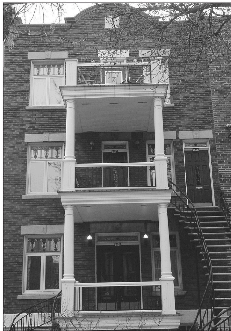
Le bois des fenêtres, des escaliers et des balcons est reconnu pour le charme qu'il dégage et l'harmonie qu'il donne aux bâtiments anciens. Pour le préserver, il est souhaité de bien l'entretenir.
