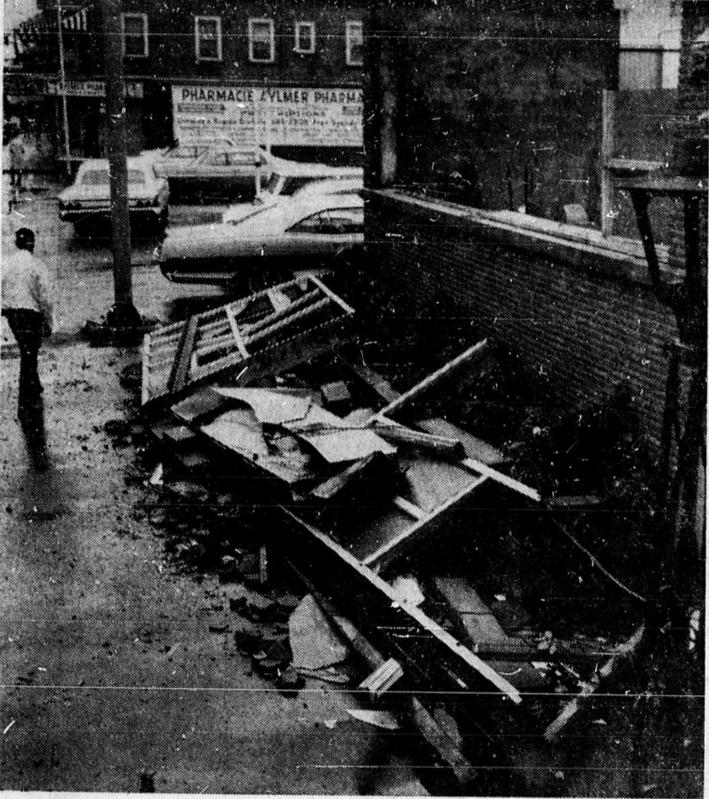
LE VENT FAIT DES SIENNES — Une bourrasque de vent a arraché une grande fenêtre quadrillée, en verre de Belgique, à l'hôtel Aylmer, au cours de la tempête, hier soir. Le propriétaire de l'établissement, M. Ernest Lattion, estime les dommages à envi-
