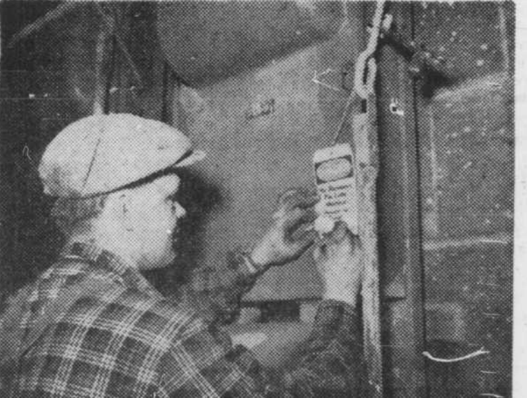
Ces vignettes illustrent l'emploi d'une pince spéciale qui permet de placer plusieurs cadenas sur un même levier de commutateur électrique. L'emploi de cette pince date déjà de plusieurs années, mais il faut la généraliser dans tous les départements et nous comptons sur la coopération de tous. Cette pince permet aux installateurs de machinerie, aux électriciens, aux préposés à l'entretien de travailler sur une même machine tout en pouvant placer leurs propres cadenas sur le commutateur.
