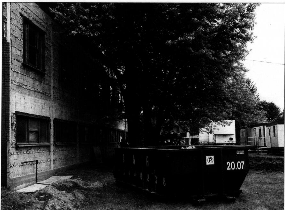
Les travaux à l'usine de filtration d'Iberville devraient être subventionnés à 60%.
