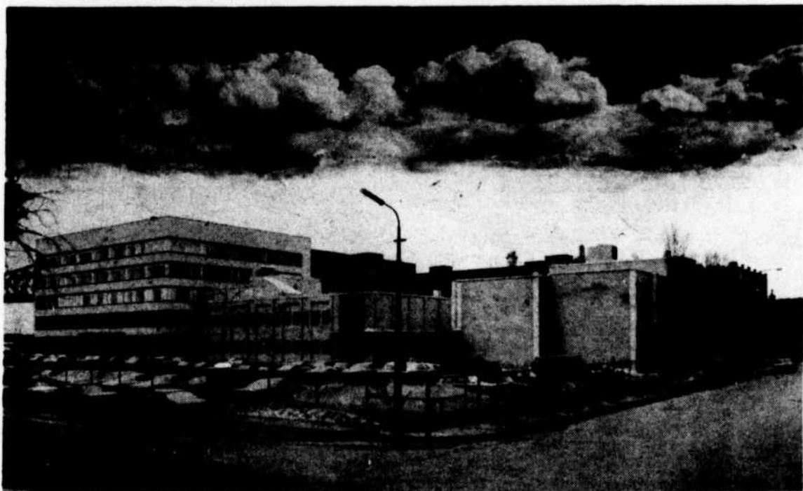
RADIO-QUÉBEC: - Les trois édifices de Radio-Québec sont situés à l'angle des rues Ste-Catherine et Fullum, dans l'est de Montréal; Les bureaux de l'administration, de la production de même que les studios y sont concentrés.
