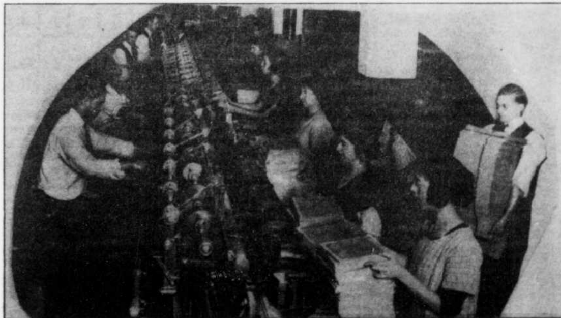
Production de l'annuaire de Toronto de 1924. La machine assemble les sections dans l'ordre approprié pour en faire des annuaires complets. Toutes les photos proviennent de la Collection historique du téléphone de Bell Canada.
