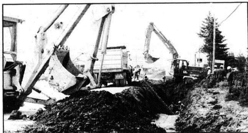
On le constate, les travaux avancent rondement.
