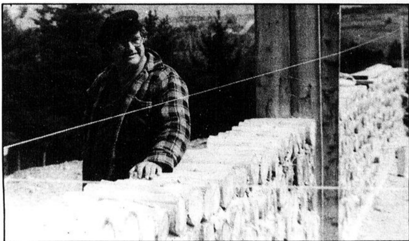
Claude Crevier s'affaire à la construction de son atelier en utilisant la technique du bois cordé.
