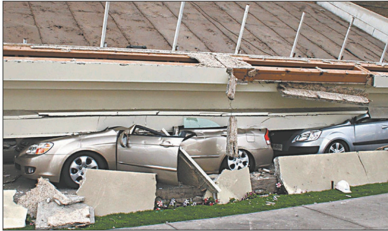
La corniche d'un hôtel a cédé hier, pendant le tremblement de terre qui secouait la ville de Tocopilla. Plusieurs voitures ont été écrasées.
