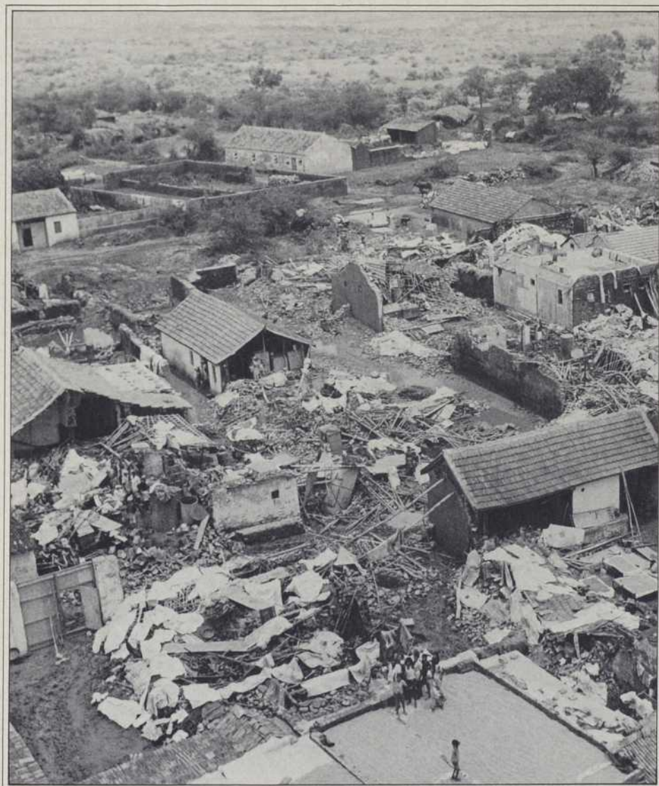
Le 11 août 1979, la rupture d'un barrage entraîna la dévastation de la ville de Morvi, au nord-ouest de Bombay en Inde. Bilan: près de 25 000 morts et une cité détruite.
