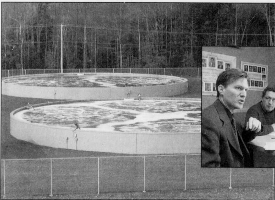
Une série de quatre bassins représente autant d'étapes dans le traitement des eaux de lixiviation.
