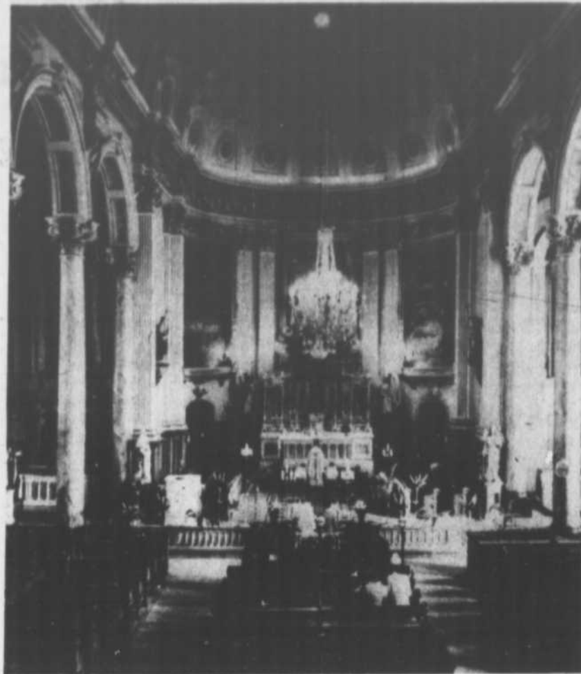
Les travaux d'aménagement du sanctuaire de l'église Saint-Louis-de-France de Terrebonne ne rendront pas la magnificence et la beauté sobre qui se dégageait avant les grands travaux des années '60. Cependant, le style roman actuel - d'ailleurs très contesté - sera épuré et rendra son cachet d'antan à l'église paroissiale. (Photo d'archives: LA REVUE)
