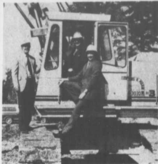
La première pelletée de terre pour l'aqueduc de La Plaine, on ne l'a pas manquée. Pour différer de la tradition, on a confié au député Jacques Parizeau le soin de lever avec la pelle mécanique une bonne pelletée de terre. On le voit ici en compagnie de M. Henri Morin des Excavation H. Morin et du maire Claude Guillemette. (Photo: LA REVUE)
