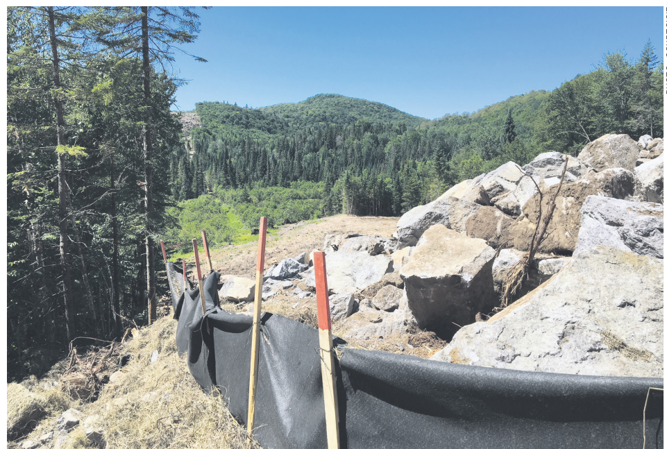
Hydro-Québec a procédé à l'installation de barrière à sédiments (toile noire), de paille de rétention et aménagé une fosse à sédiments (non visible sur la photo).
