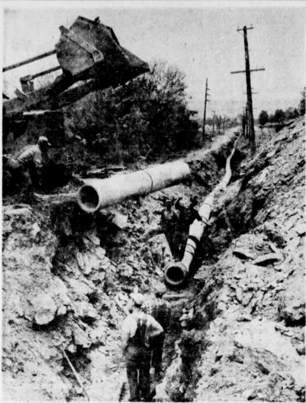
LE TUYAU DU NOUVEAU RESERVOIR, CHEMIN BECKETT — Le réservoir d'une capacité de 5,000,000 de gallons, que l'on est à construire dans le quartier Nord, sera terminé d'ici un mois et demi, selon l'ingénieur Jacques Lemieux. On est à parachever, sur le chemin Beckett, la pose d'un tuyau de 18 pouces de diamètre qui conduira l'eau dans le nouveau réservoir.
