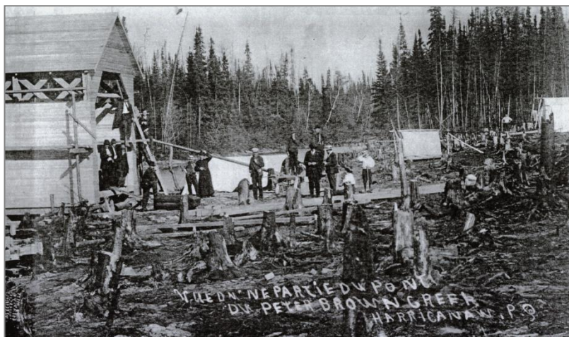
↑ 1914, construction du pont couvert
