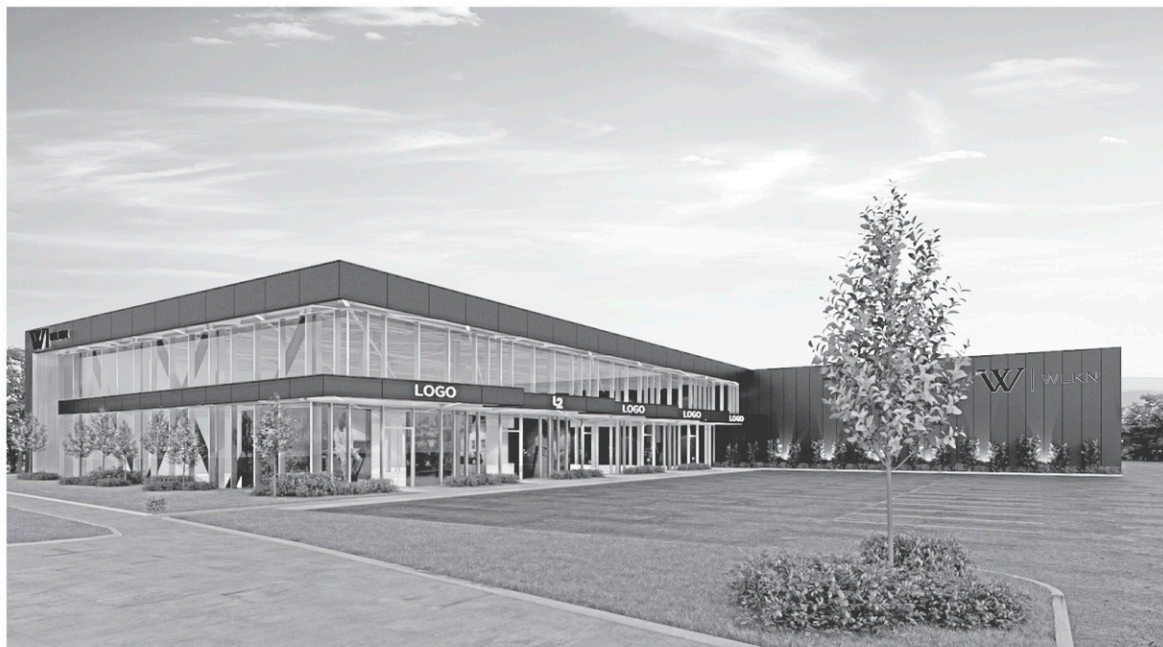
L'édifice qui hébergera le nouveau siège social de WLKN sera d'une superficie de 60 000 pieds carrés.
