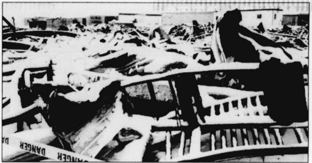
Les installations d'Hébertville sont une perte complète. Autour de l'ancien site de l'usine, les roulottes attendent que l'on ait trouvé un local temporaire pour subir les modifications requises dans les contrats décrochés par l'entreprise.
