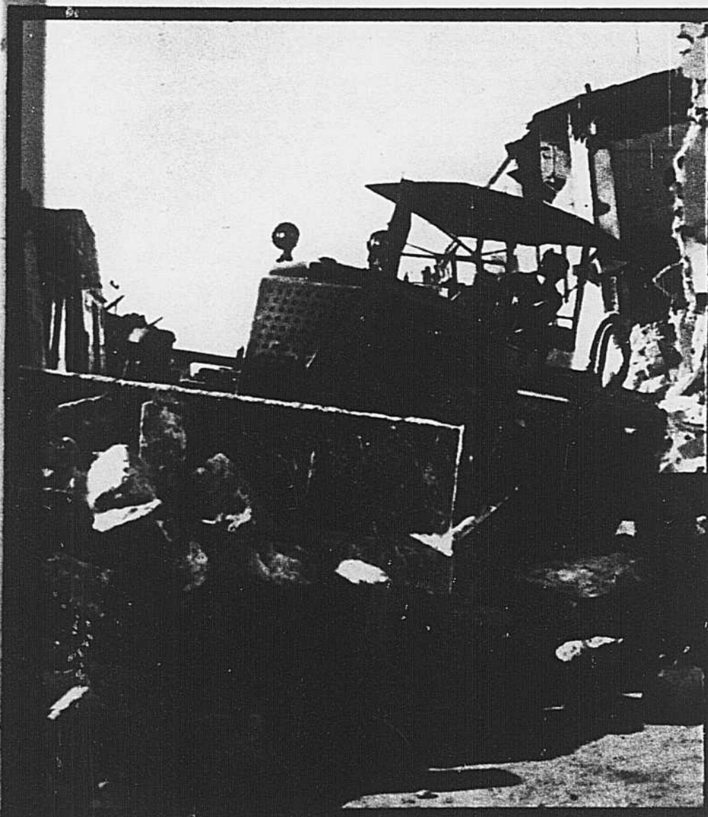
Les rues dévastées de Montevago, on déblaye les ruines au bulldozer.
