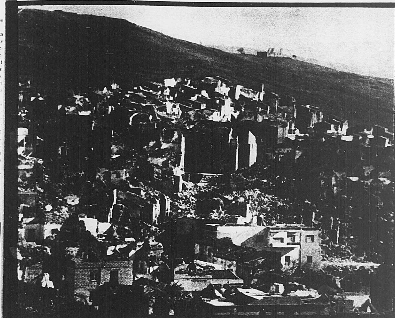
Une partie d'un village quasi totalement détruit.
