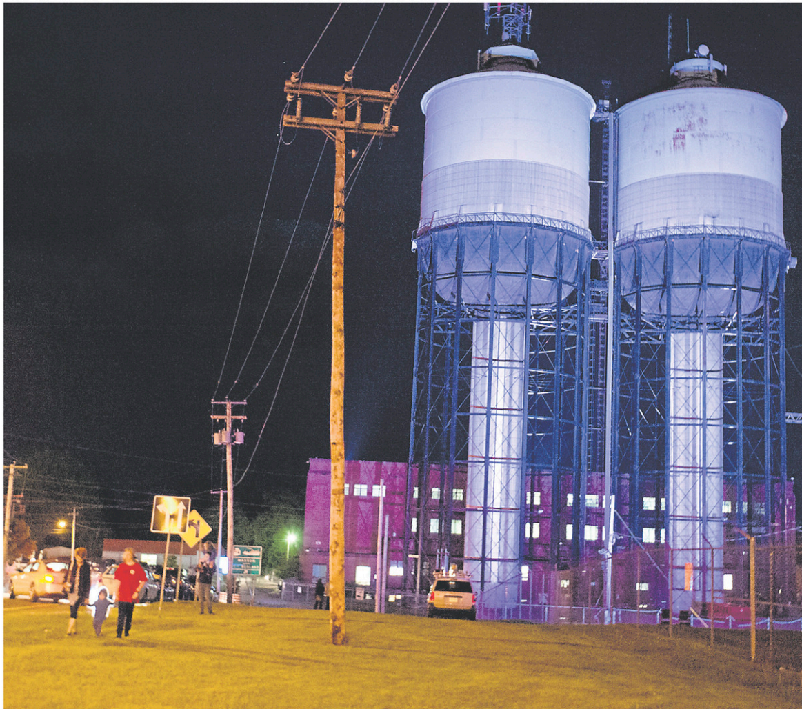
Les cheminées d'équilibre sont éclairées grâce à 13 projecteurs sur le toit de la centrale et au sol contenant des millions de lumières DEL. — MARTIN ROY, LE DROIT
