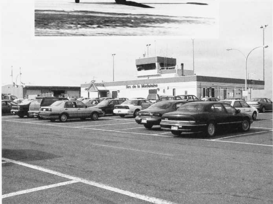
Aéroport de Havre-aux- Maisons. (Photo Normand Perron)
