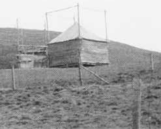
Baraques à foin permettant d'entreposer à peu de frais le fourrage des animaux. Un système de poulies permet d'élever ou d'abaisser le toit. (Photo Paul Larocque)
