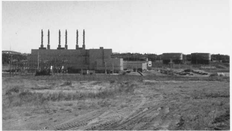
La centrale thermique de Cap-aux-Meules. (Photo Normand Perron)
