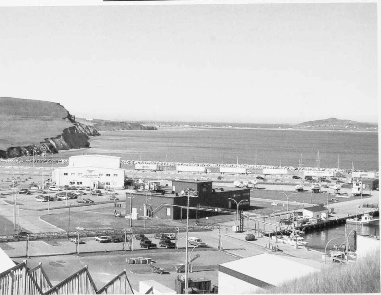
Une partie des installations portuaires du quai de Cap-aux-Meules. (Photo Normand Perron)
