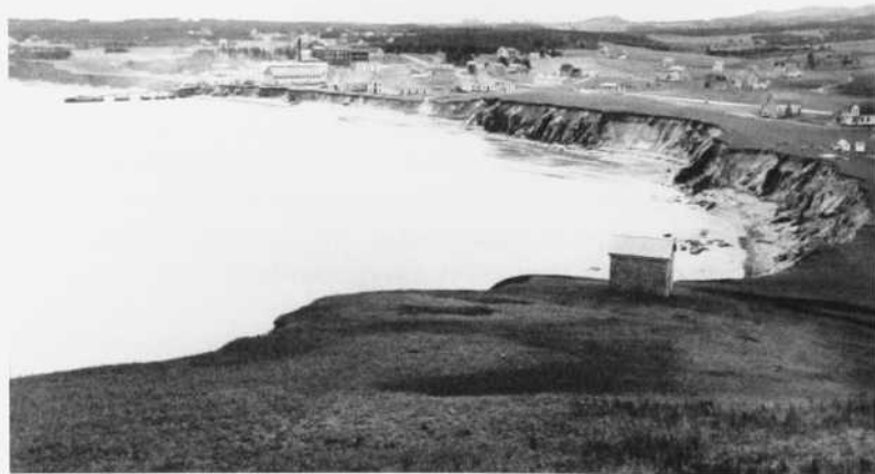
La partie ouest du village de Cap-aux-Meules avec les fumoirs Sumarah et l'hôpital. On distingue, au loin, l'église de La Vernière. (Coll. Musée de la Mer. Office de publicité du Québec, 36 602-1947)
