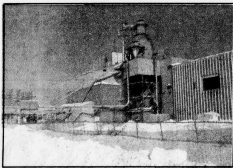
L'ex-usine Cascades de Port-Cartier.
