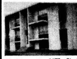
11 logements 1477 Sirois Mont-Joli
