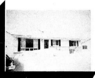
Rue Normandie St-Pie X. Bungalow - entrée sous-sol - Terrain aménagé.
