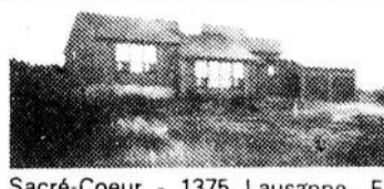
Sacré-Coeur - 1375 Lausanne. En pleine nature. Construction moderne 1978 à paliers multiples, 1412 p.c. terrain 46,000 p.c. Garage.
