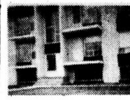
11 logements 1467 Sirois Mont-Joli
