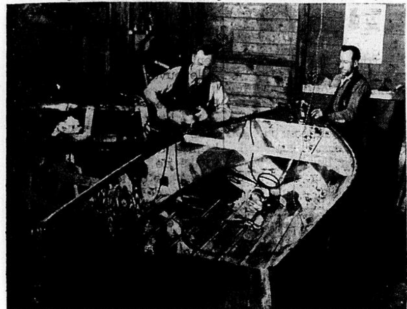
● MM. Albert Trottier, contremaître et Laurent Gauthier mettant la dernière main à l'une des fameuses chaloupes en aluminium construite par: Les Produits d'Aluminium de Chicoutimi.
