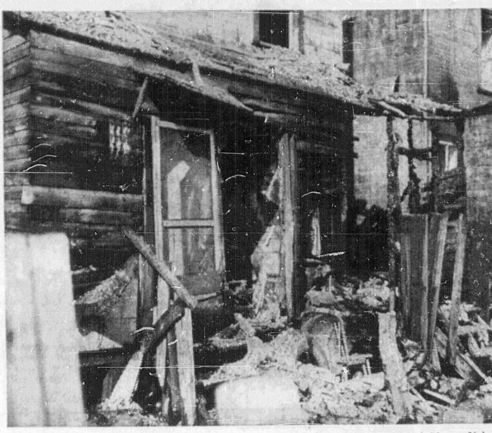
TRENTON SANS-LOGIS — Voici la remise où s'est déclaré l'incendie qui a ravagé six logis et délogé 30 personnes, de 61 à 71, rue Nelson, la nuit dernière. (Photo Champlain Maréchal)
