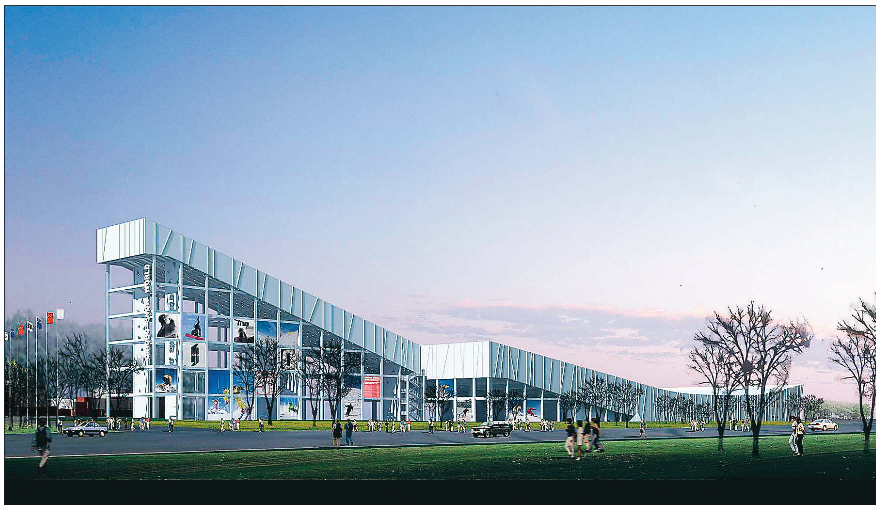
La mini piste de ski intérieure de Pékin fera 45 mètres de hauteur et le système de réfrigération de Cimco fournira la neige artificielle nécessaire à la descente. PHOTO COURTOISIE CIMCO
