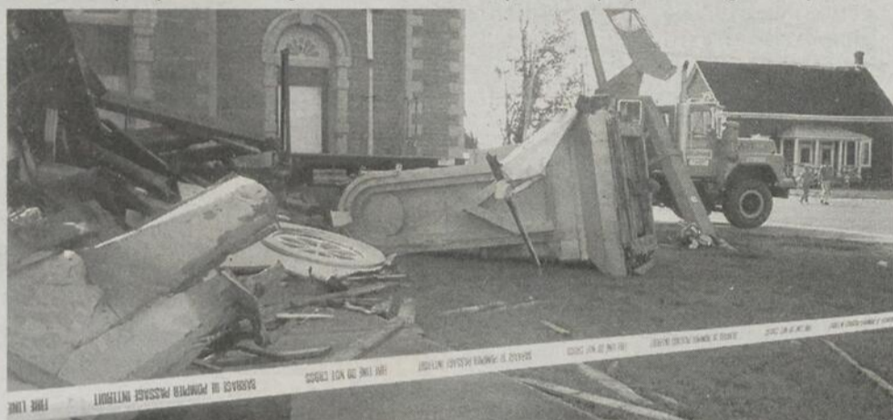
Les clochers de l'église de Maskinongé ont été projetés au sol par les forts vents qui ont atteint 300 kilomètres-heures. Photo, gracieuseté Centre de Ressources en Impacts et Adaptation au Climat et à ses Changements (CRICC)
