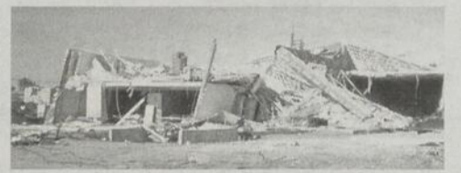
Les maisons, industries, granges ont été pulvérisées comme des châteaux de cartes en cet inoubliable 27 août 1991...
