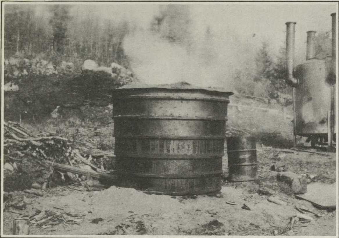
Fig. 19- Four Delhommeau, en opération.
