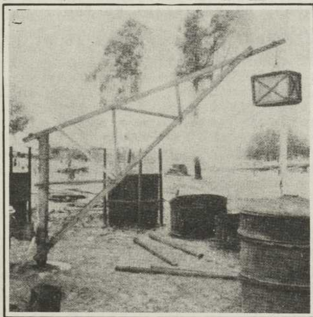
Fig. 15b. Défournement du charbon de bois au moyen d'une grue tournante.
