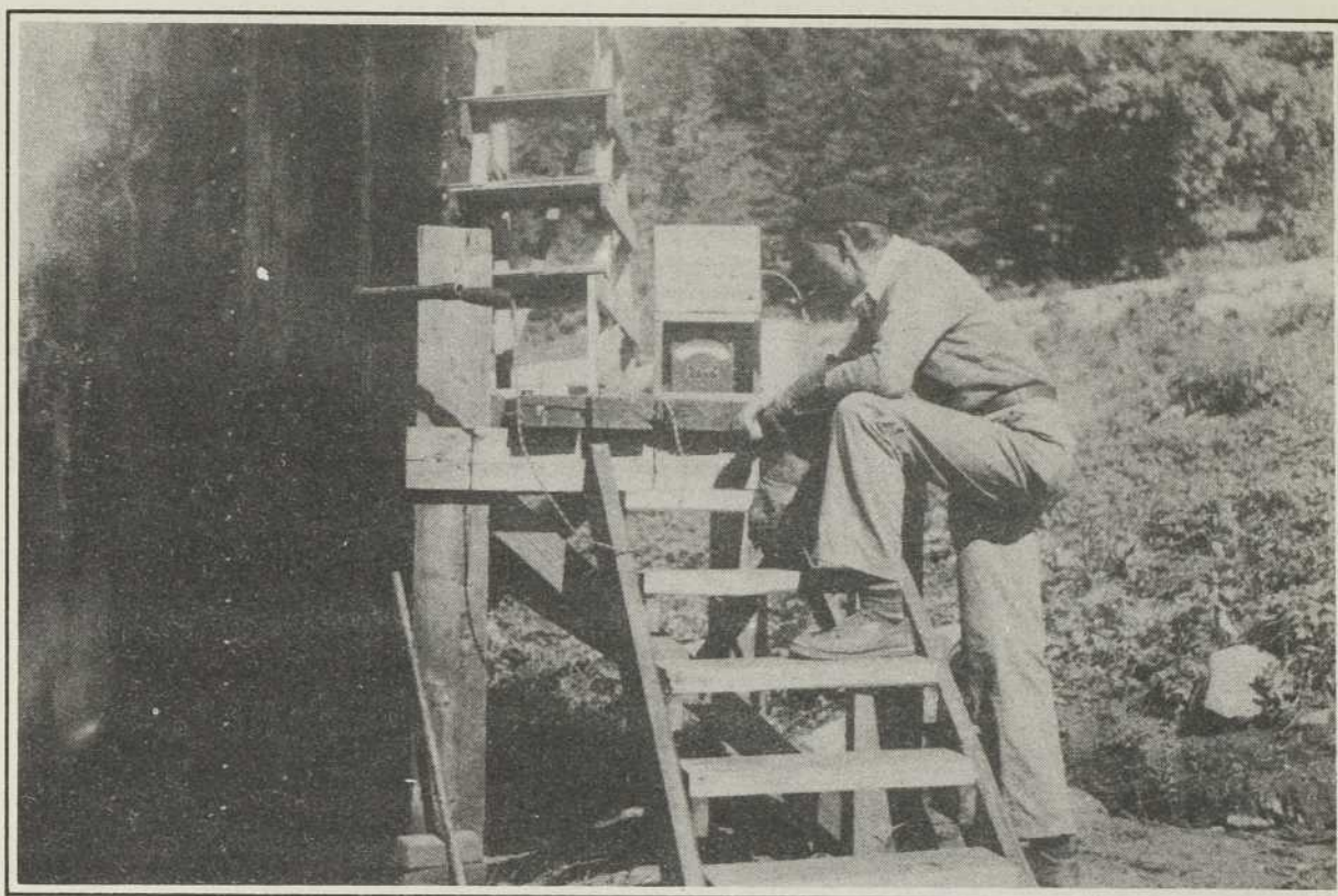
Fig. 27 - Installation d'un pyromètre électrique pour le contrôle de la température de carbonisation.
