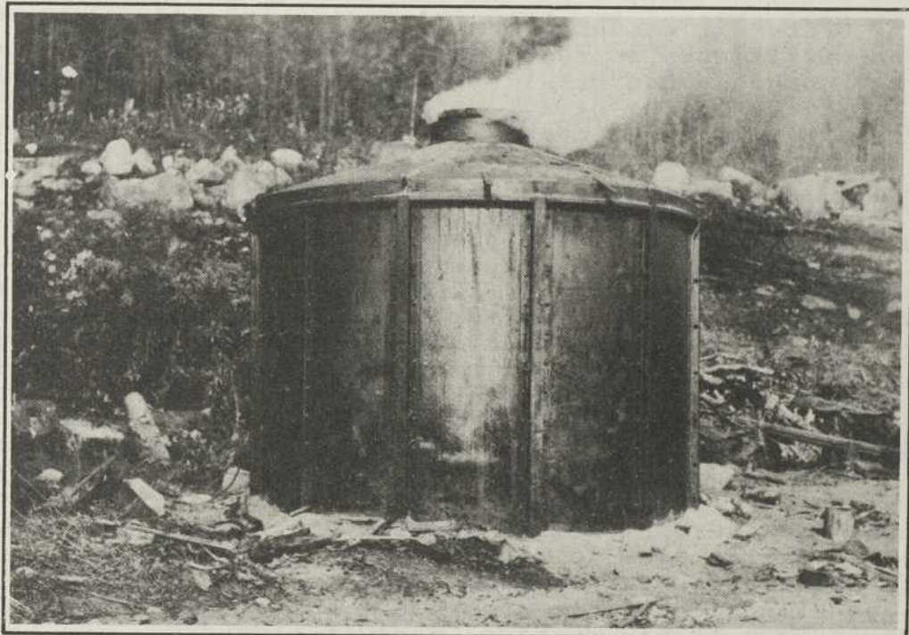
Fig. 18 - Four Trihan, en opération.
