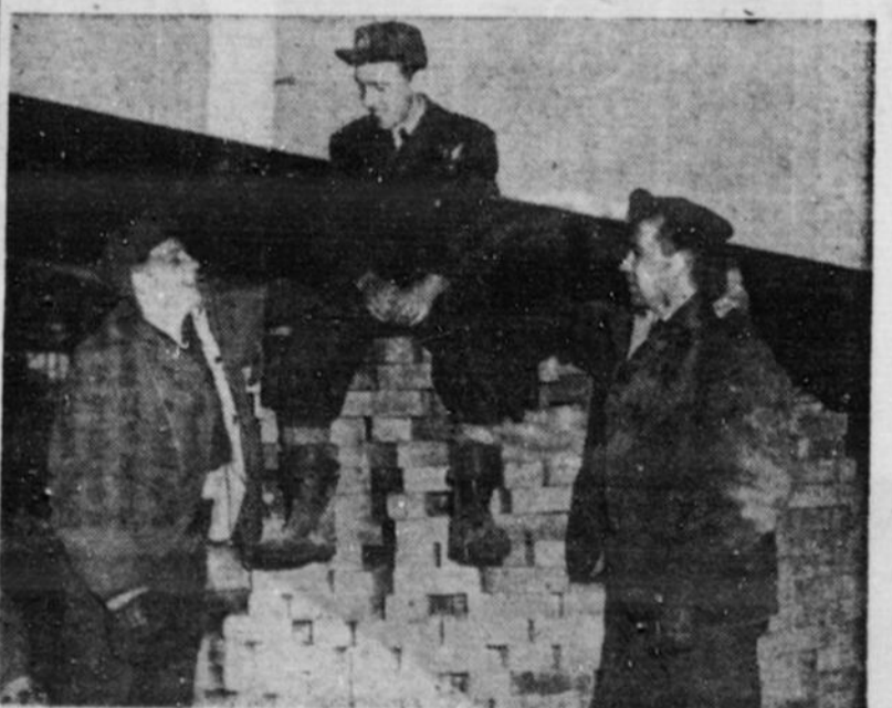
ON SE DEBROUILLE. — La construction ci-dessus n'est peut-être pas un chef-d'œuvre d'architecture, mais elle a cependant une importante raison d'être: elle protège les gardes de la base du CARO à Gros-Tenquin contre la pluie et le vent. De gauche à droite: les aviateurs P. H. Bowman, de Toronto, Georges Piché, de Montréal et Charles Goretzki, de Winnipeg. La 3e escadre de chasseurs représente une partie de la contribution du Canada à l'OTAN et compte les 416e, 431e et 430e escadrilles pilotant des Sabres réactés.
