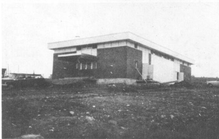
Le Centre Culturel de Lac Etchemin est pratiquement terminé. On procède actuellement aux travaux de terrassements et on met la dernière main à l'édifice lui-même. Cette construction a été rendue possible grâce à la collaboration des gouvernements supérieurs avec les autorités municipales de ville Lac Etchemin et sera un monument pour commémorer le centenaire de la confédération canadienne. On sait par ailleurs que le Ministère des Affaires culturelles du Québec est à mettre au point un programme d'utilisation de ces centres culturels en vue justement de diffuser le plus largement la culture à travers le Québec.
