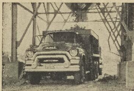
Prêt à recevoir la première charge! La hotte s'ouvre et ce solide camion GMC reçoit des masses de roches. 14½ tonnes de pierre à chaux représentent une lourde charge... mais il est construit pour résister à tout!
