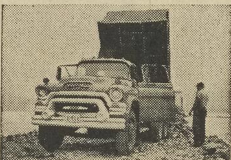
La livraison est faite. George aide à construire ce dock, grâce à la performance de son GMC W-9900. Pour l'apparence, la capacité de travail et l'économie, les camions GMC sont imbattables!
