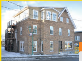
RIVIÈRE-DU-LOUP Rue Lafontaine
