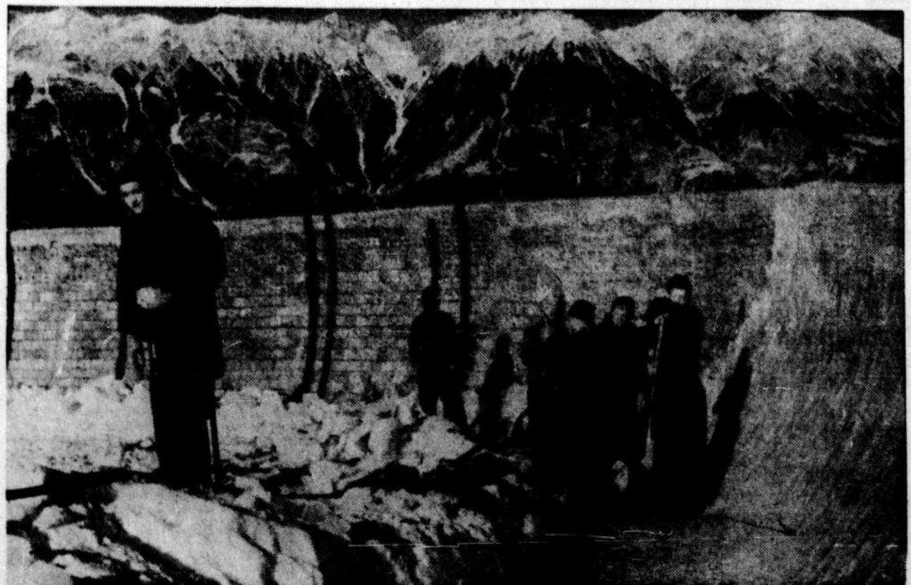
La descente pour bobsleigh est en voie de préparation en vue des Jeux olympiques à Innsbruck. Les parois sont de blocs de glace qui seront cimentés par de la neige fondue.
