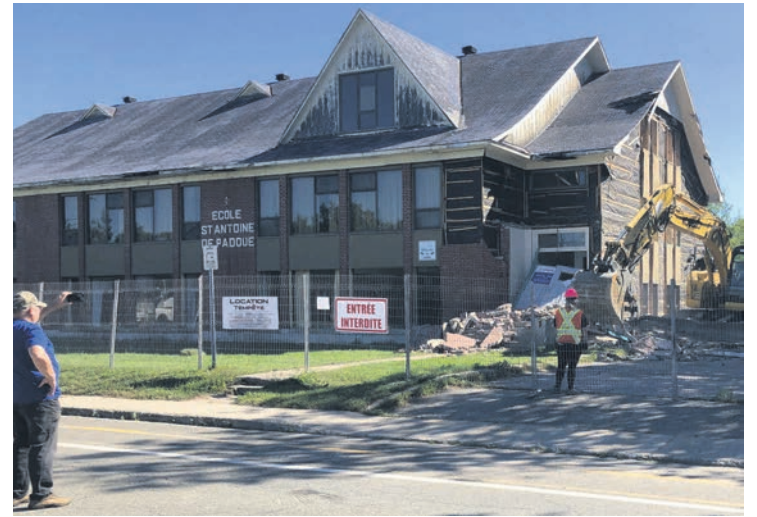
C'est la démolition pour l'école Saint-Antoine-de-Padoue de Clarke City.
