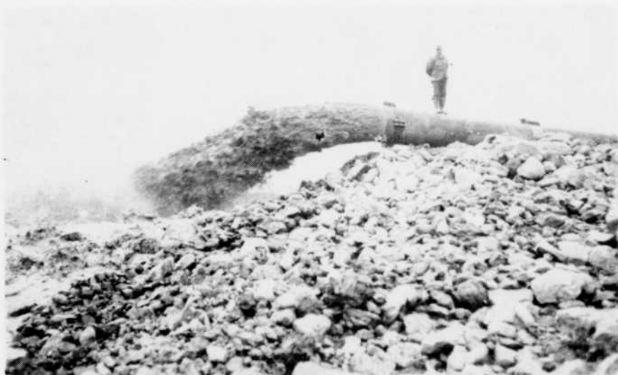
Bout de la conduite de refoulement de la drague "Hydro-Québec". On peut voir un dépôt de pierre qui a été refoulé.
