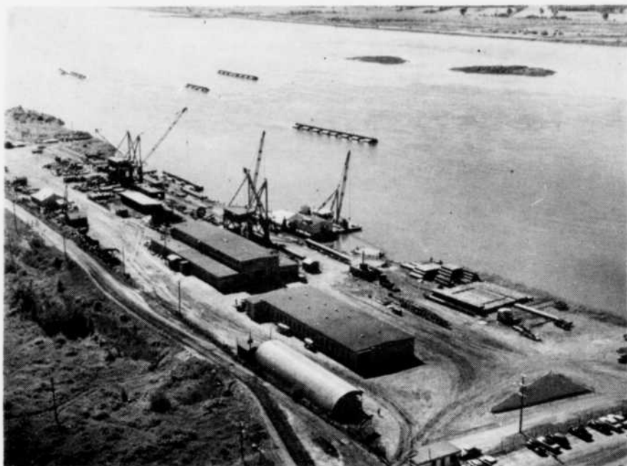
Les ateliers et entrepôts servant les opérations de dragage du canal.
