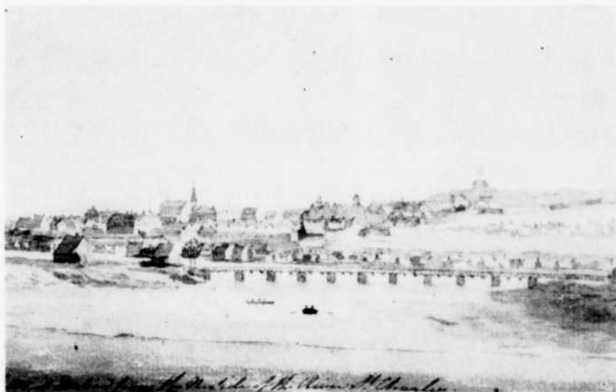
Le premier pont sur la rivière St-Charles, à Québec, construit en 1789.
