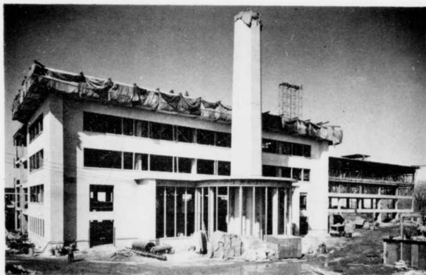
Vue de la chaufferie à l'arrière de l'immeuble.
