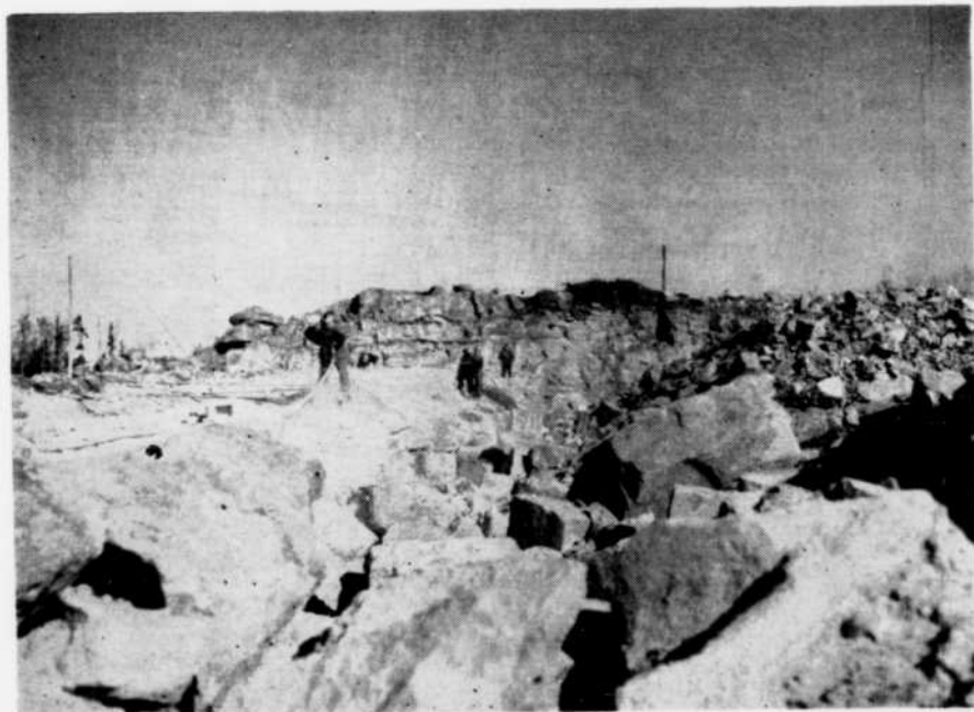
Un aspect du rude terrain qu'il faut niveler avant la construction de l'aluminerie.
