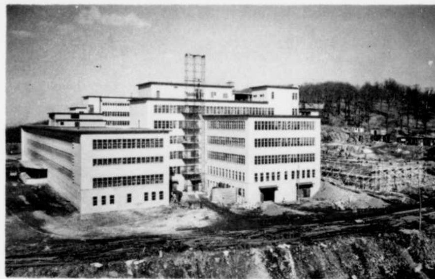
Vue du côté ouest du nouvel immeuble.
