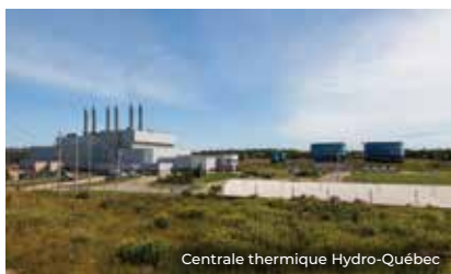
Centrale thermique Hydro-Québec
