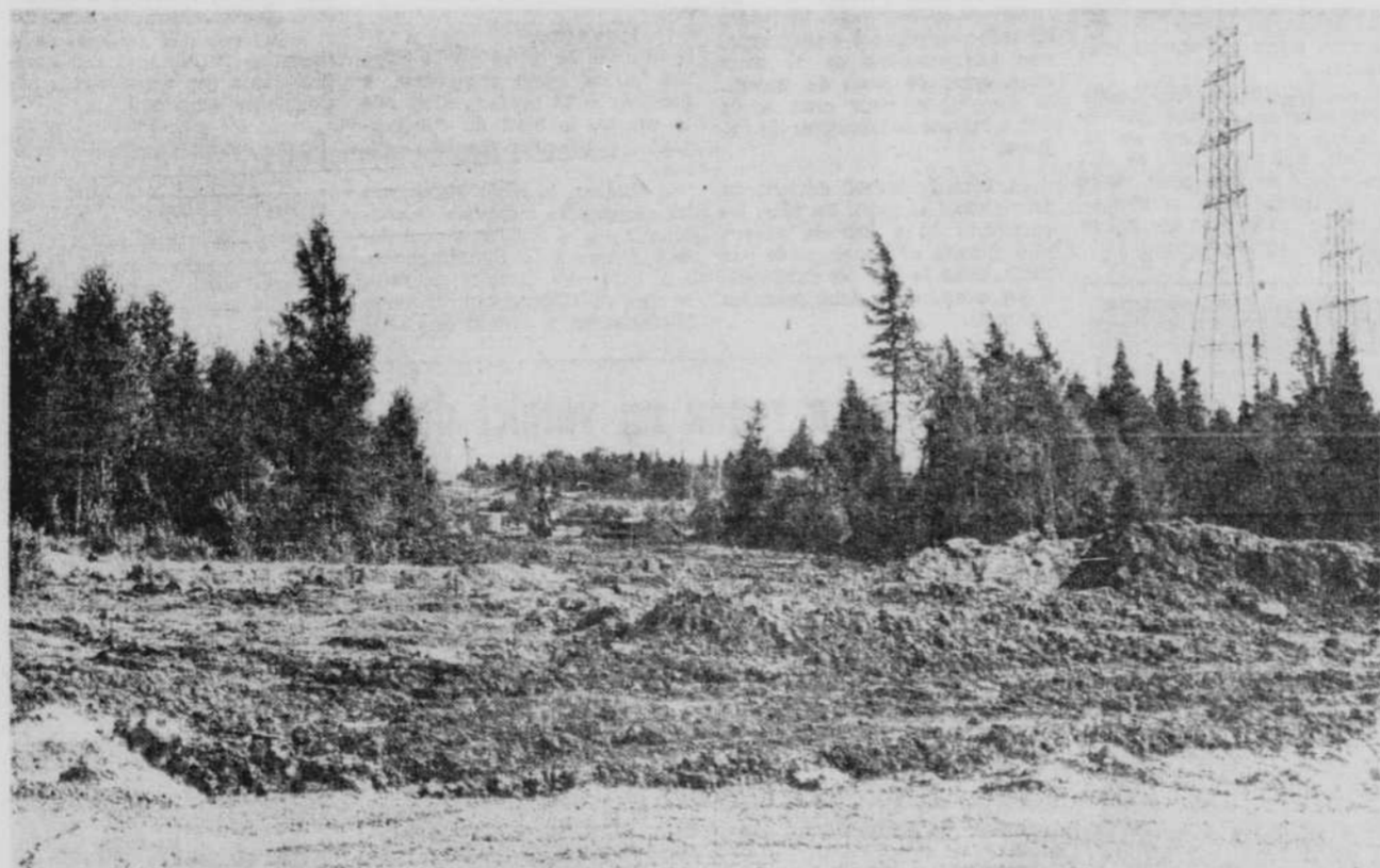
FUTUR BOULEVARD — Mois après mois, de nouveaux quartiers domiciliaires viennent se greffer autour du centre d'Orsainville. Ci-dessus, au loin, une grue mécanique dans un terrain
