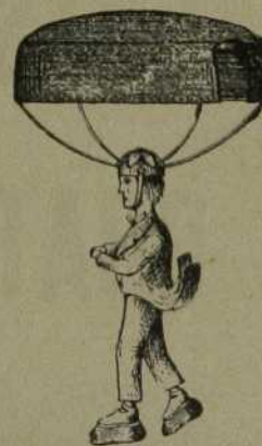
Parachute de sauvetage en cas d'incendie.
