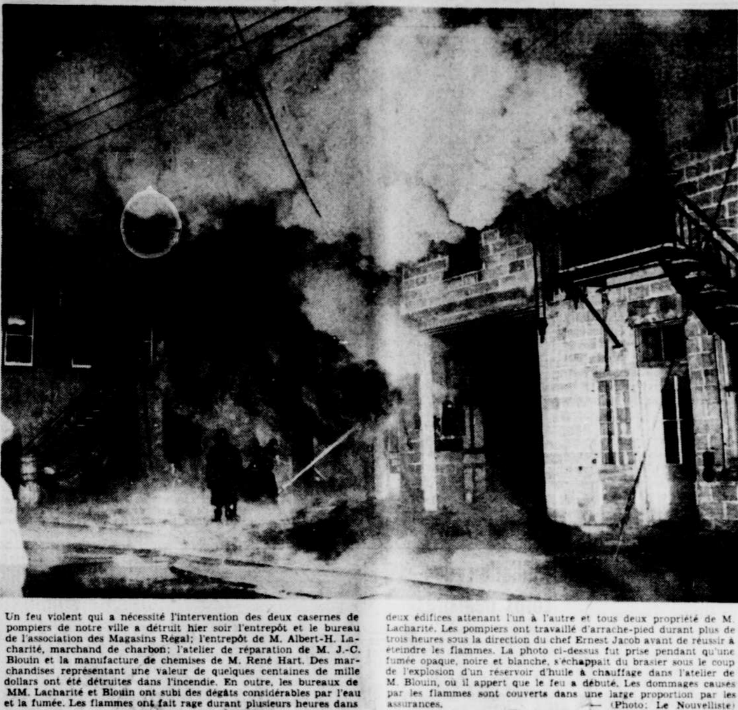
Un feu violent qui a nécessité l'intervention des deux casernes de pompiers de notre ville a détruit hier soir l'entrepôt et le bureau de l'association des Magasins Régals; l'entrepôt de M. Albert-H. Lacharrie, marchand de charbon; l'atelier de réparation de M. J.-C. Blouin et la manufacture de chemises de M. René Hart. Des marchandises représentant une valeur de quelques centaines de mille dollars ont été détruites dans l'incendie. En outre, les bureaux de M. M. Lacharrie et Blouin ont subi des dégâts considérables par l'eau et la fumée. Les flammes ont fait rage durant plusieurs heures dans
