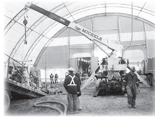
Équipement de forage dirigé dans le bâtiment temporaire.
