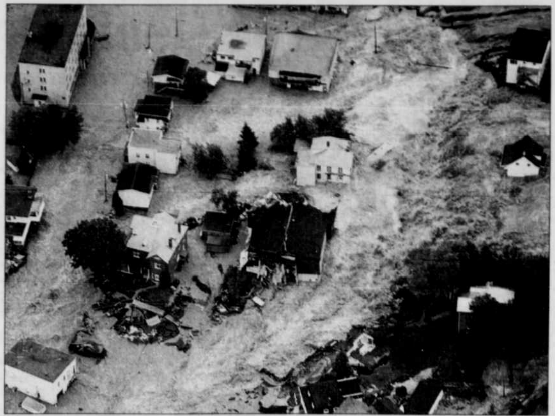
Impossible de nier les dommages subis dans la région du lac Kénogami et de la rivière Chicoutimi.
