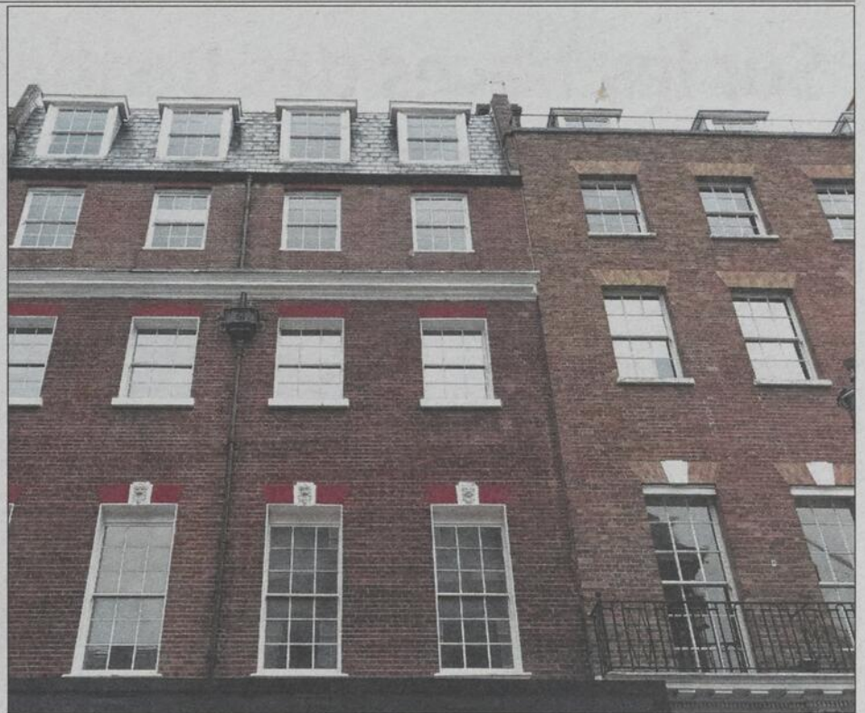
C'est sur ce toit d'un immeuble de Saville Row que se sont produits les Beatles pour le film Let It Be .
