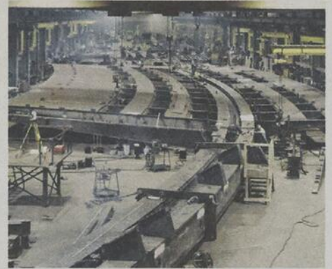
Le groupe ADF investira la somme de quelque 24 M$ US pour la construction d'un nouveau complexe de fabrication de charpentes métalliques à Great Falls, dans l'état du Montana.
