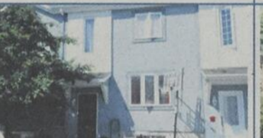
LA PLAINE. Cottage en rangée 3 cdc, foyer au bois, 2 espaces de stationnement et plusieurs rénovations au fil des années. Près de tous les services et écoles.
